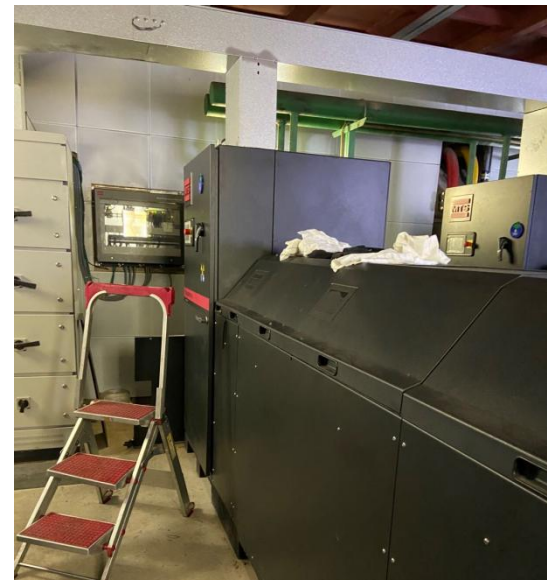
某工厂液压油源监测
